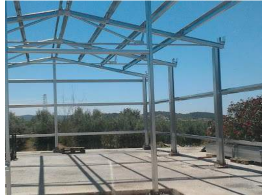
Figura 2.2 Estructura de acero. Fuente: navesindustriales.trabajosenvertical.com
