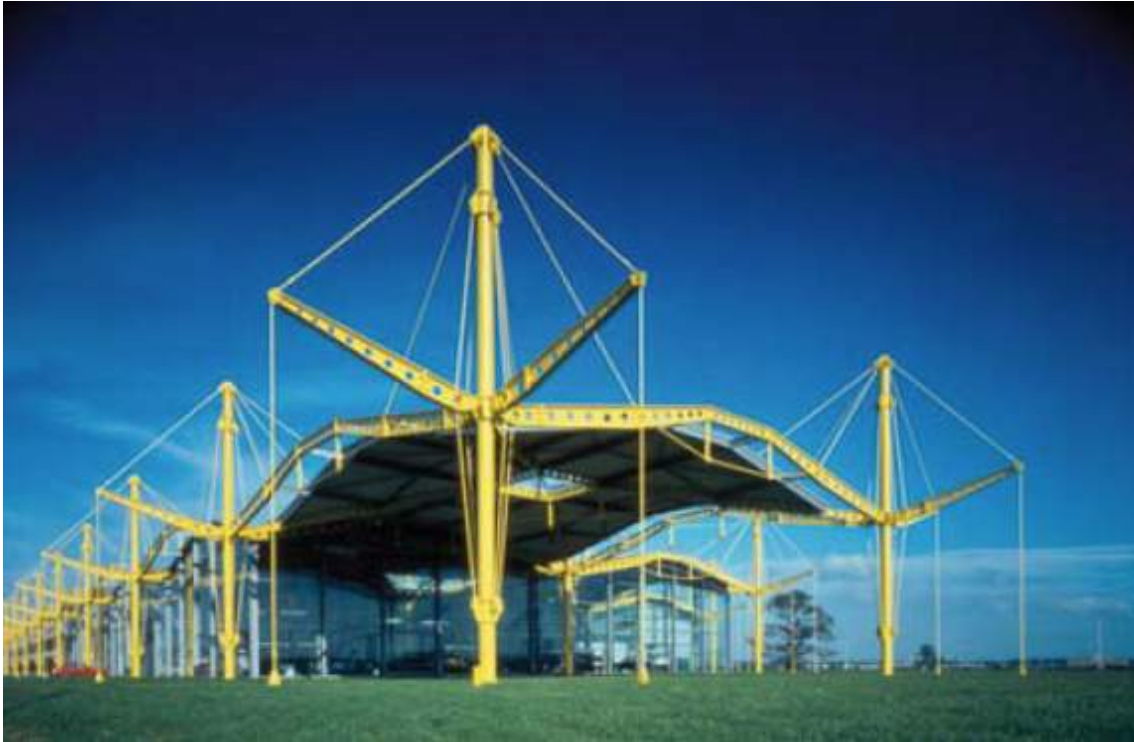
Figura 2.26. Estructura suspendida de la fábrica de Renault en Swindon, UK (1980's). Fuente: Buenas Prácticas para la Construcción en Acero. Edificación Industrial
