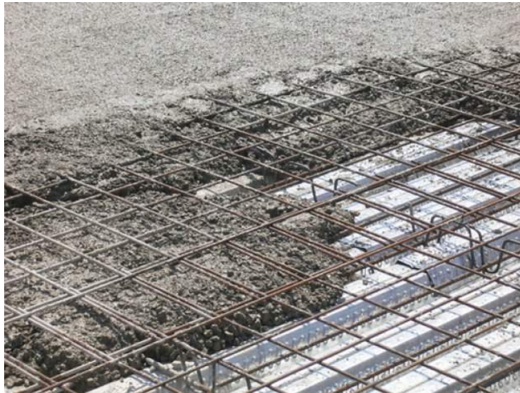
Figura 3.3. Montaje de Forjado colaborante. Fuente: www.clgeng.com
