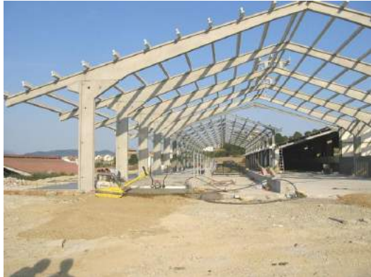
Figura 2.1. Estructura de hormigón. Fuente: www.tomaria.es
