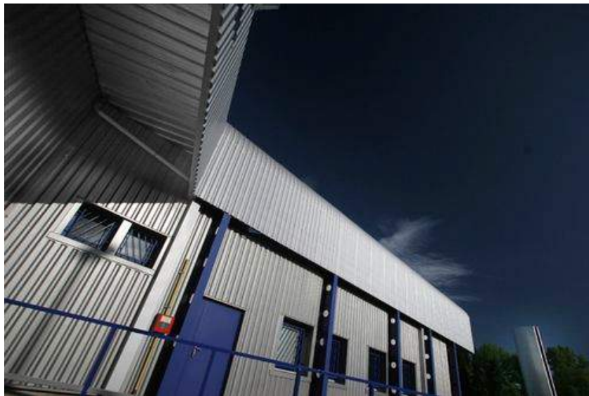
Figura 2.6. Nave revestida de paneles perfilados de acero. Fuente: www.cubiertasyfachadas.net
