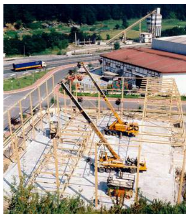
Figura 2.3. Montaje de nave metálica. Fuente: www.ferrocal.es
