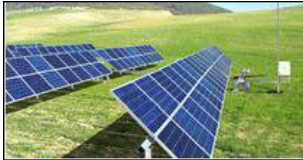
Ilustración 15. Sistema de seguimiento solar en un eje horizontal.
