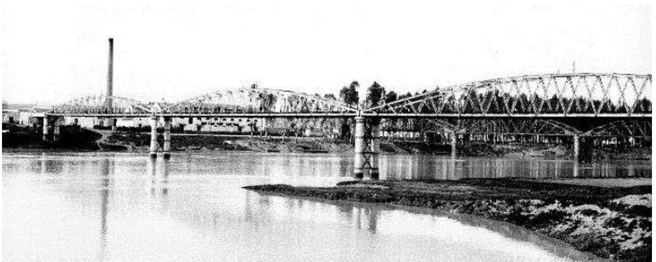
Figura 3-1: Pasarela del agua. Puente del ferrocarril Sevilla – Huelva al fondo.
