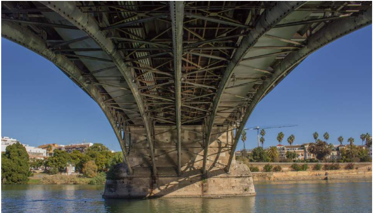
Figura 3-3: Entramado de arriostramientos
