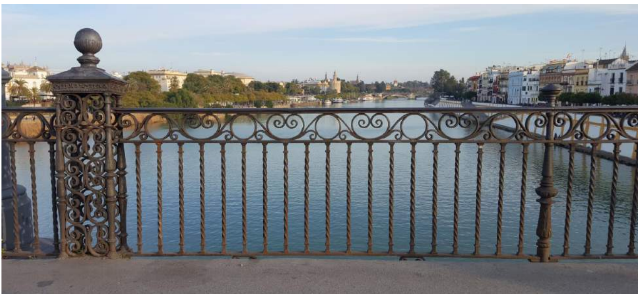
Figura 3-4 Conjunto de elementos presentes en la barandilla
