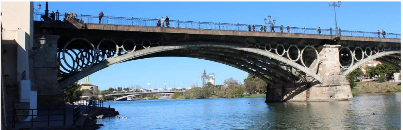
Figura 3-5: Estribo oeste y pila central
