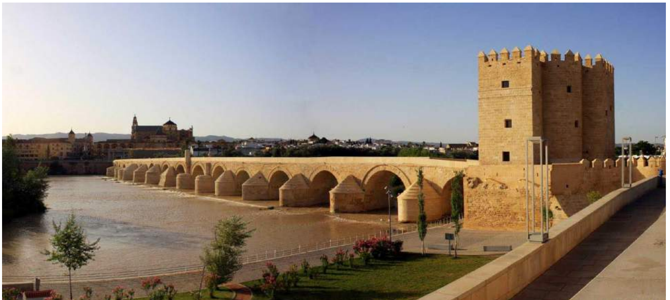
Figura 2-1: Puente romano de Córdoba
