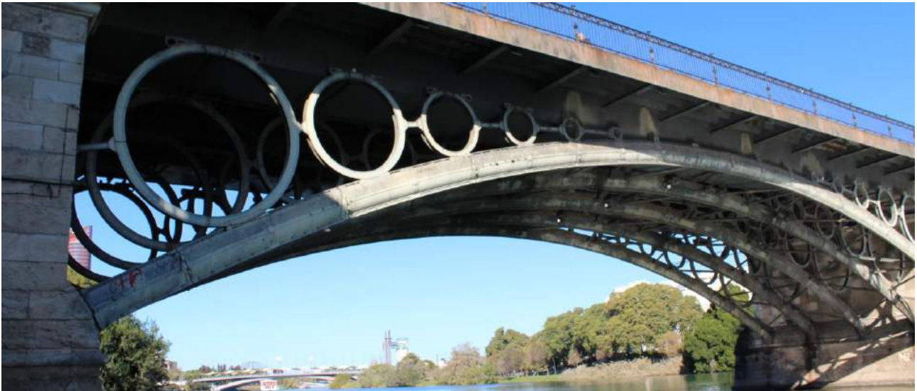
Figura 3-2: Elementos de la división de anillos y arcos
