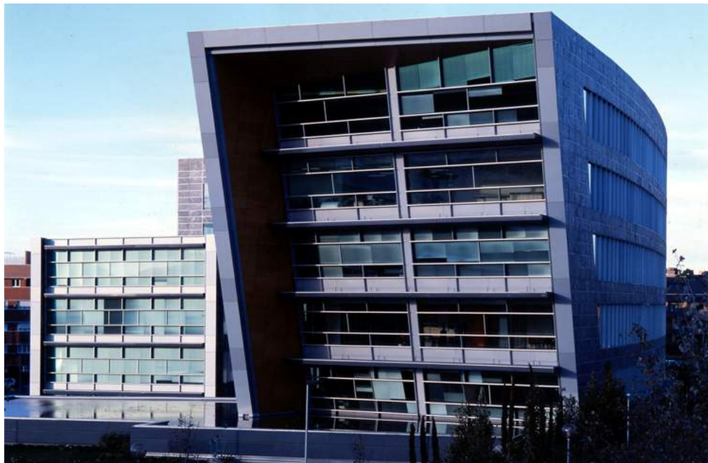
Ilustración 2: Imagen de fachada principal
