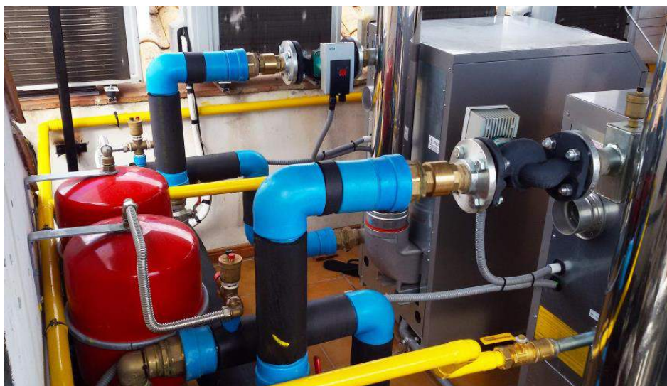
Figura 32: Calderas Biasi Powercond con quemador de microllama y ventilador de velocidad variable
