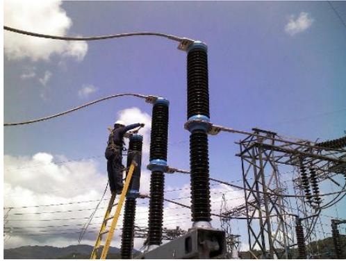
Figura 3-7. Mantenimiento correctivo de un interruptor. [14]
