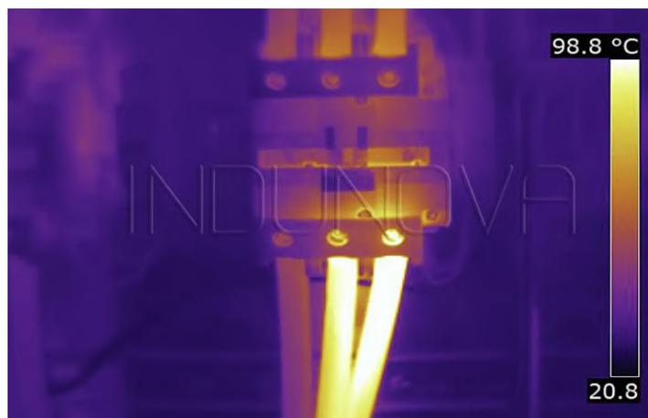
Figura 4-15. Conexiones con sobrecalentamiento [37]
