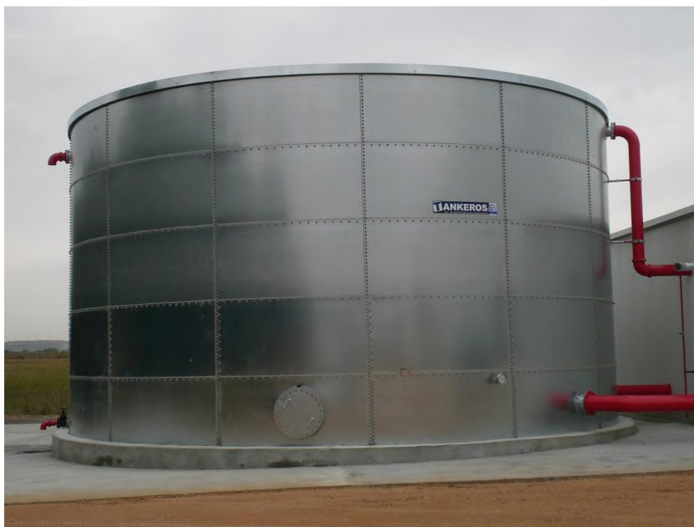
Figura 5-1. Depósito de base circular en la realidad.
