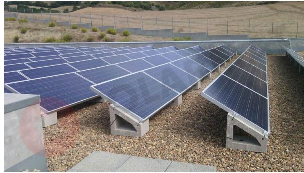
Ilustración 2.9 Estructura módulos FV.
