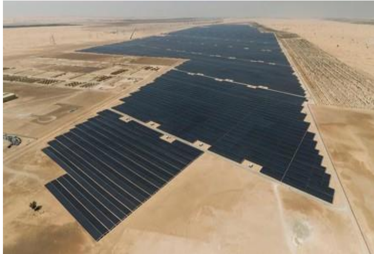
Ilustración 2.3 Mayor planta fotovoltaica del mundo con 3,2 millones de paneles en Abu Dhabi.
