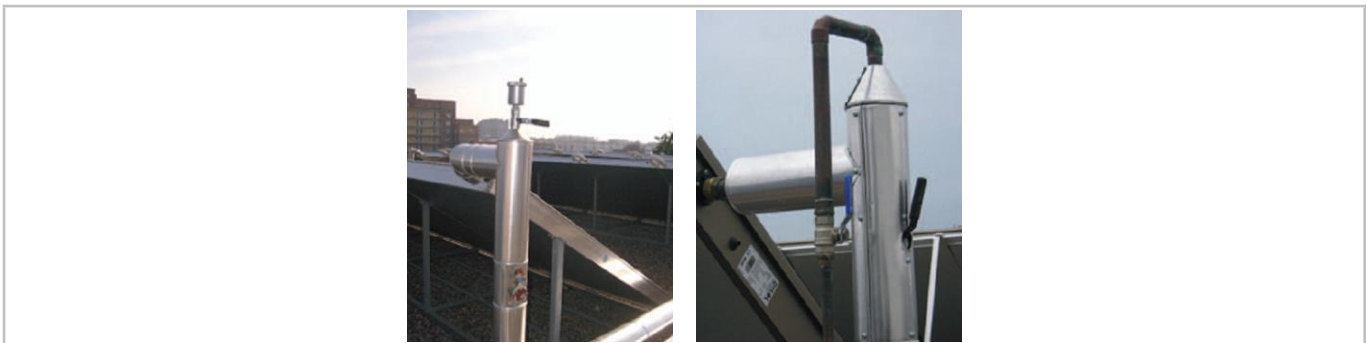
FIGURA 4-23 PURGADOR AUTOMÁTICO CON VÁLVULA (IZQ.) Y SISTEMA DE PURGA MANUAL (DER.)
