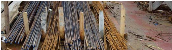
Estiba en planta para trabajo en banco (Sistema que ocupa gran espacio en obra)
