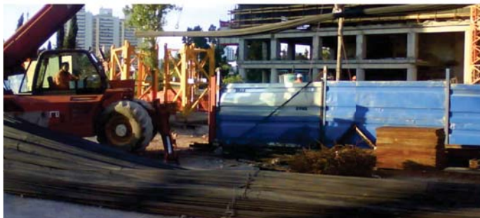
Estiba en planta para trabajo en banco (Sistema que ocupa gran espacio en obra)
